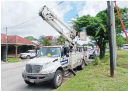
La colocación de luminarias la realizaron técnicos de la estatal eléctrica.
