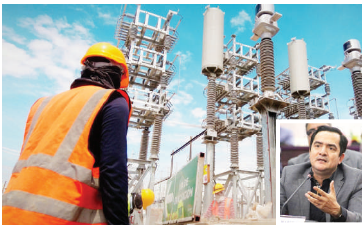
Las reformas al sector eléctrico buscan introducir cambios para enfrentar los problemas que atraviesa el sistema energético nacional.
