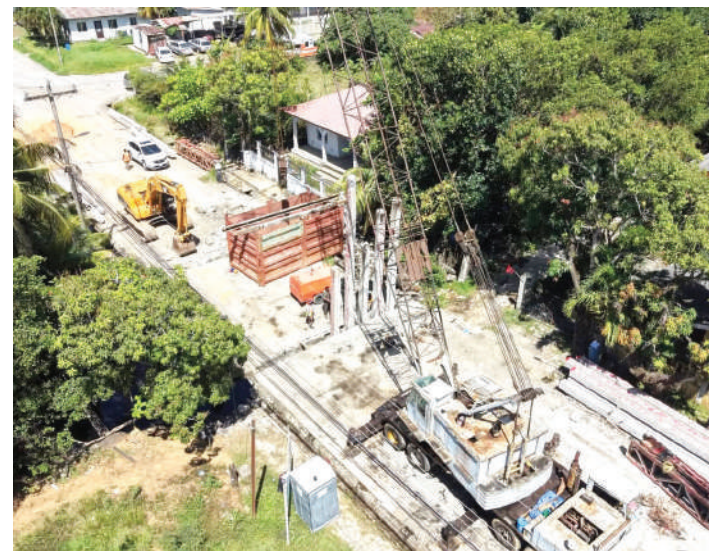
Se espera habilitar este puente antes de Semana Santa.
