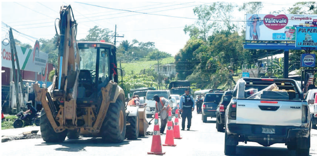
Trabajos de bacheo en la carretera interfronteriza CA-13 se realizan bajo la conducción de la constructora Eterna.
