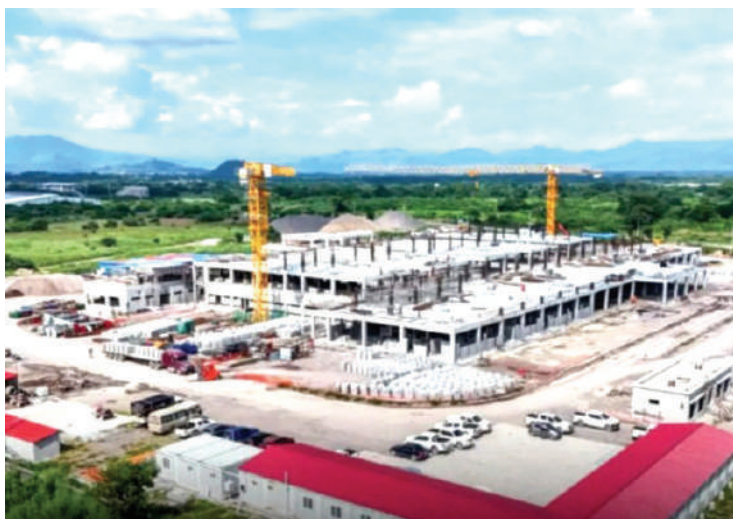
Vista aérea de la construcción del Hospital del Sur, proyecto hospitalario valorado en 100 millones de dólares.
