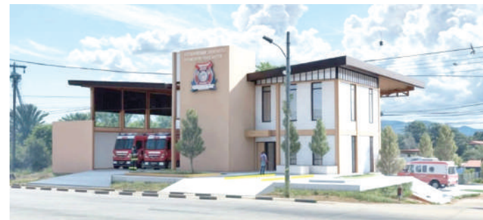
Se aprobaron las bases de licitación de la subestación bomberil.
