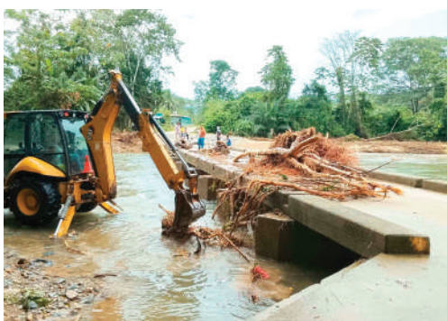
Maquinaria municipal retira sedimentos y troncos para restablecer el paso afectado por las lluvias.
