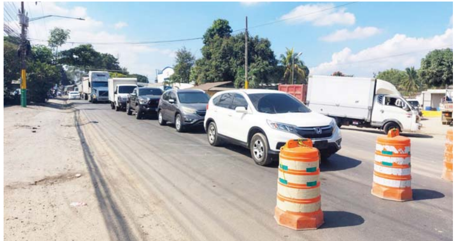
Esta carretera será de cuatro carriles. Terminarán los atolladeros viales que se dan a diario en El Progreso.
