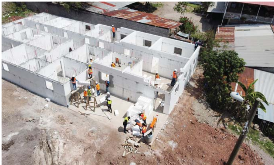
En 60% avanza la construcción del primer edificio del Policlínico de Santa Rita, Copán.
