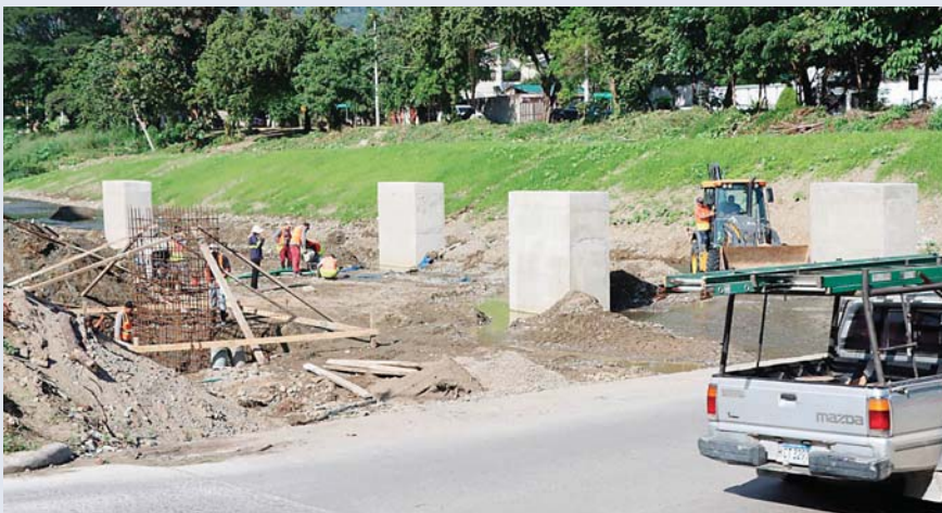
El proyecto de mejoramiento del vado Colombia comprende la construcción de losas de pavimento de 990 metros cuadrados y sistema pluvial.
