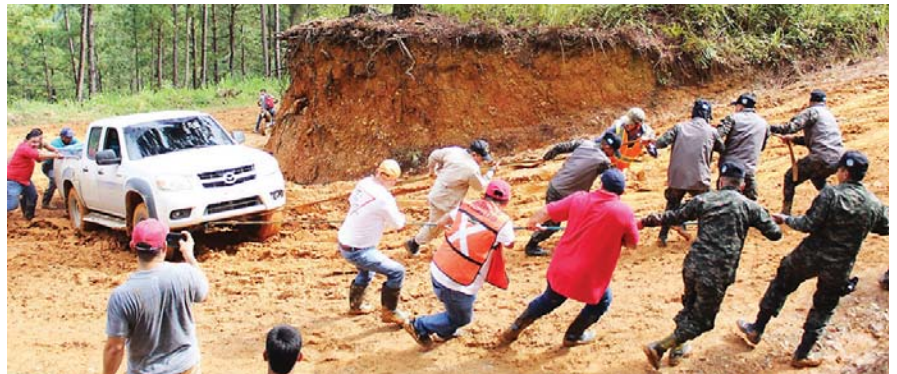
Esperan que, con dos o tres días de sol, poder poner la maquinaria a trabajar en estas carreteras.
