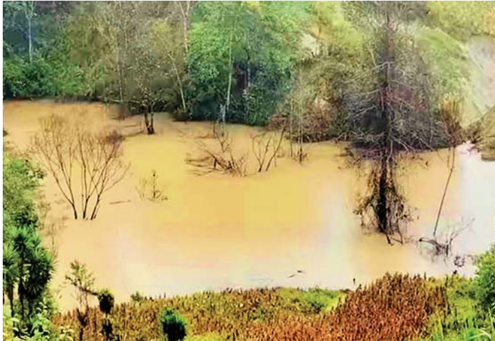
El dique que se ha formado en Aldea Nueva en Santa Rita, Copán, sigue derrumbándose y preocupa a los pobladores.
