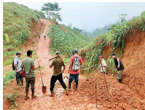
El paso para llegar al Tapón de los Oros quedó interrumpido.
