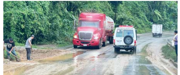
La carretera interfronteriza CA-13 sigue abierta a pesar de los derrumbes.
