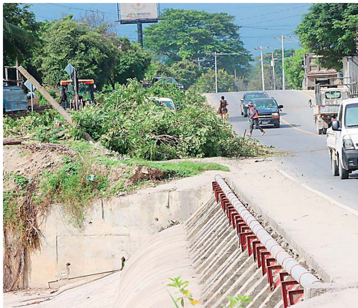
Lo primero que se construirá será el puente sobre la quebrada.
