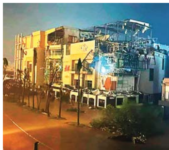
Edificios y otras construcciones quedaron completamente dañados, tras el paso del fenómeno climático.
