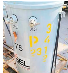
Actualmente se están atendiendo solicitudes para sustituir transformadores.
