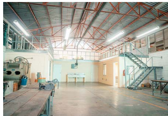
Los equipos municipales realizaron trabajos de cimentación, pedestales, columnas y vigas metálicas, entpiso con canaletas metálicas, lámina de aluzinc y piso de concreto.
